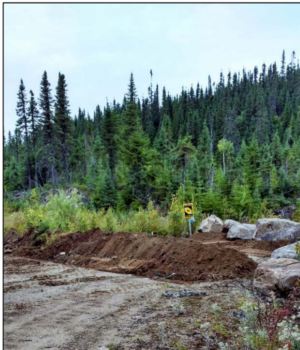
Photo 1 Fermeture avec empierrement et tranchée
