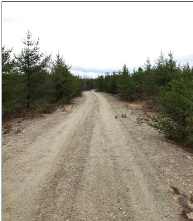
Photo 5 Chemin E-123, début de fourche, enrésinement progressif
